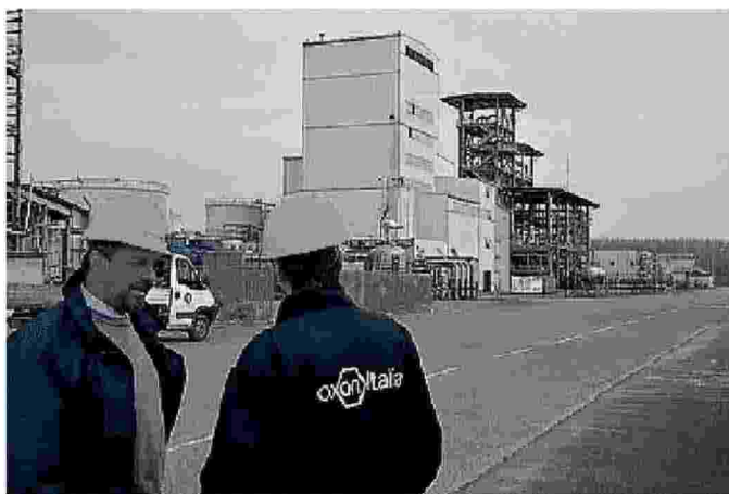
LA SEDE L'impianto Oxon di Mezzana Bigli. Nella foto grande, Eugenio Pallucca, direttore tecnico della società (Spf e Torres)
